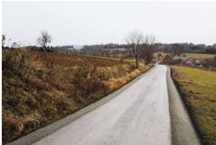
Droga gminna „Kalinówka” w miejscowości Słona na Suchą Górę o długości 1,4 km wykonana w ramach środków „powodziowych” z Ministerstwa Spraw Wewnętrznych i Administracji. Łączny koszt: 554 tys. zł, w tym dotacja z MSWiA – 439 tys. zł, tj. 80% wartości zadania (2020 r.).
