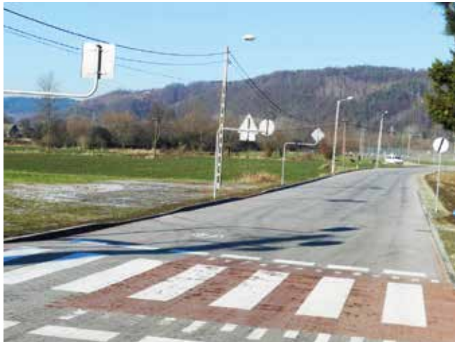
Ul. Kamieniec w Zakliczynie – remont dzięki pieniądżom z Funduszu Dróg Samorządowych. Łączny koszt: 480 tys. zł, dotacja ze środków rządowych – 384 tys. zł, tj. 80% wartości zadania. (2019 r.).
