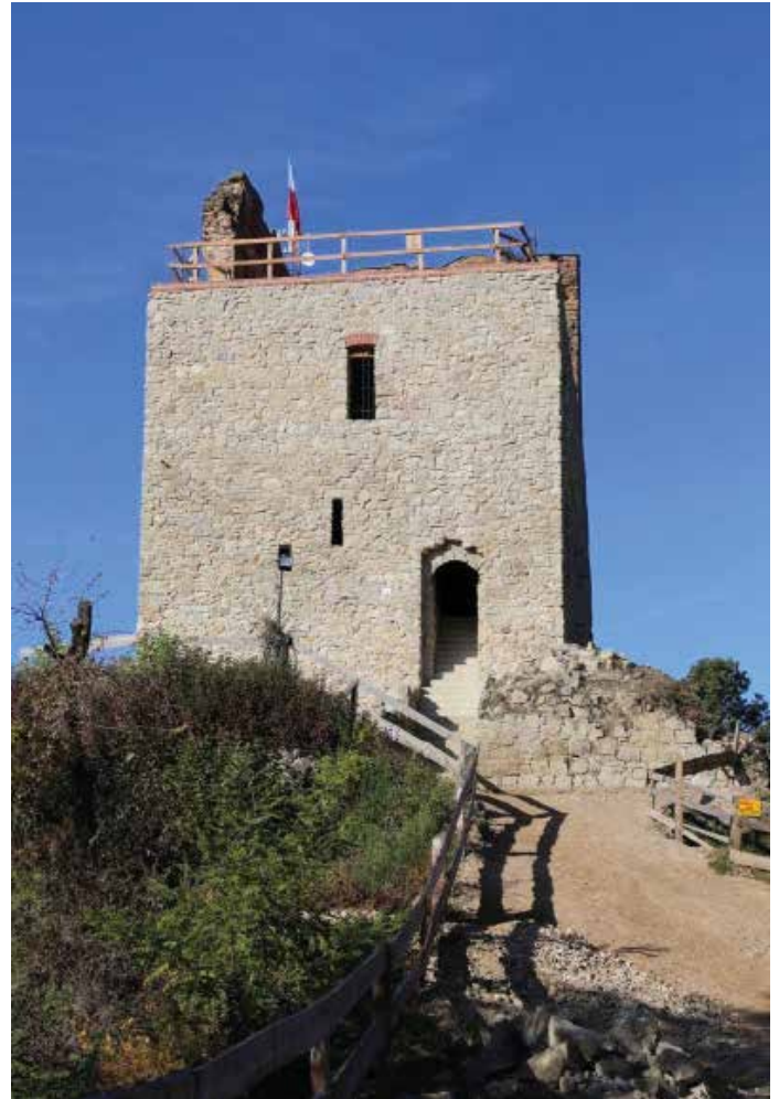
Z odbudowywanej wieży zamku w Melsztynie można już podziwiać piękne widoki na dolinę Dunajca i Beskid Sądecki
